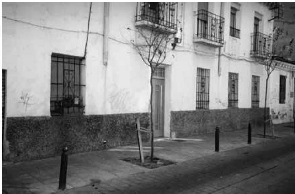
Fig. 8. Calle Figueras. En la imagen puede apreciarse como en algunos edificios —calle Figueras núm. 30— se han sustituido elementos constructivos exteriores que no guardan ninguna correspondencia con los existentes.
