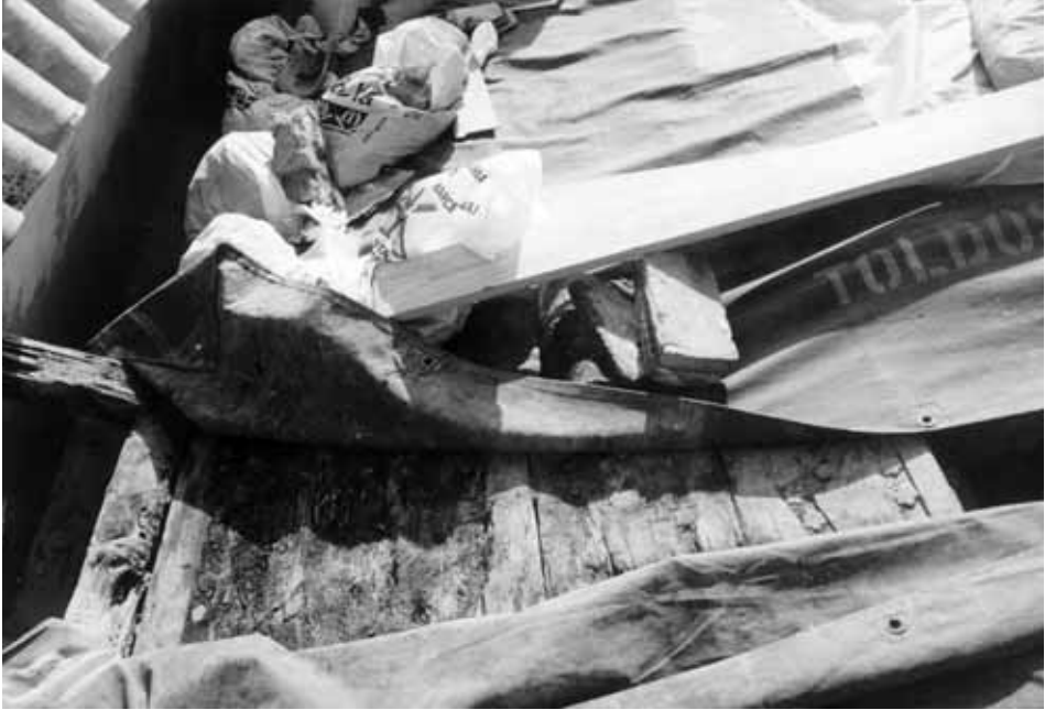
Fig. 6. Córdoba. Catedral. Imagen de las obras realizadas en abril de 1.999 en la cubierta actual, donde puede verse un tablero de la techumbre de al-Hakam II colocado haciendo de ripiá.
