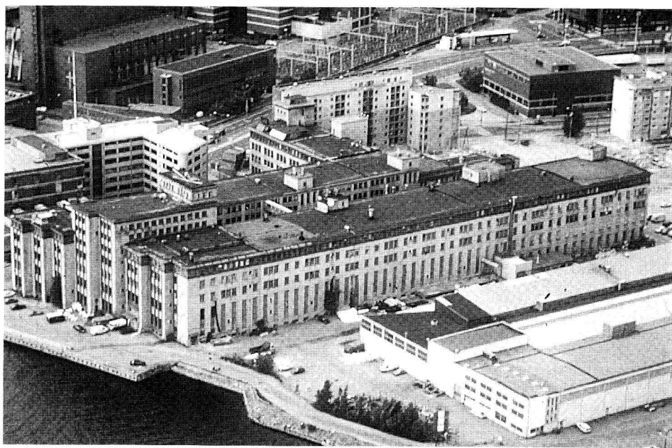
Fig. 7. Kaapelitehdas, Helsinki: otro enorme complejo mixto de espacios para artistas y para el público, en una factoría portuaria de cables.
