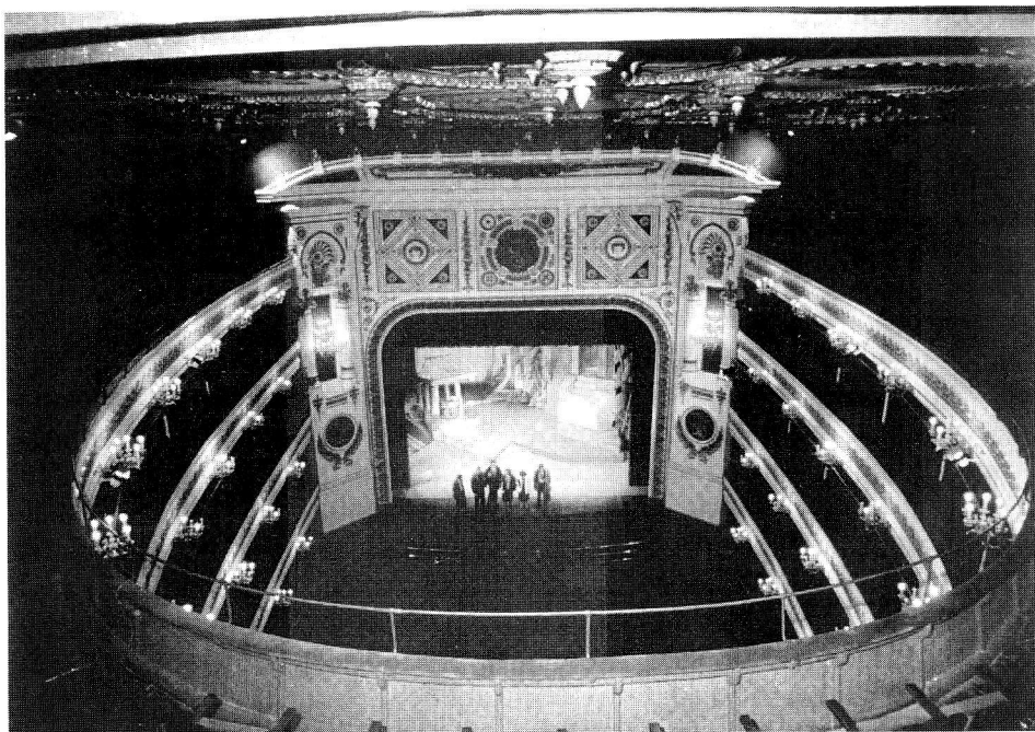
Fig. 10. Vista de la sala reformada, 1997.
