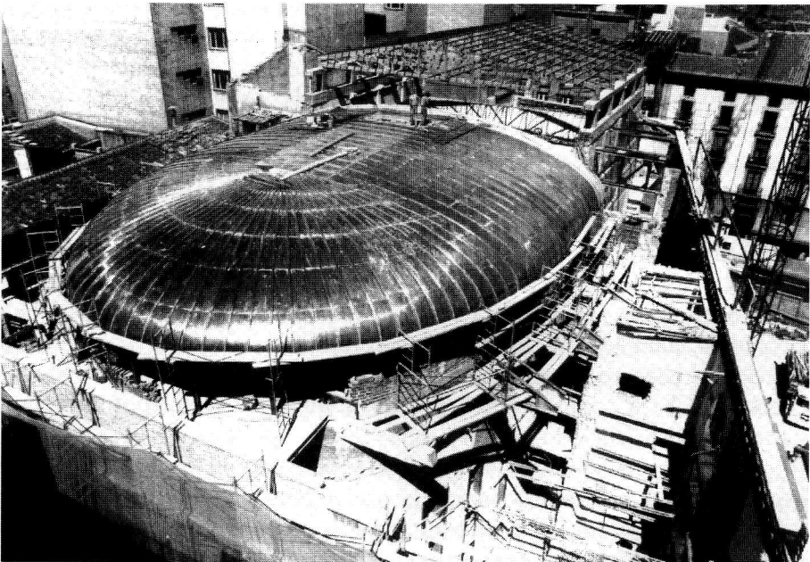
Fig. 9. Nueva cubierta de la sala y pabellón de escena, 1987.
