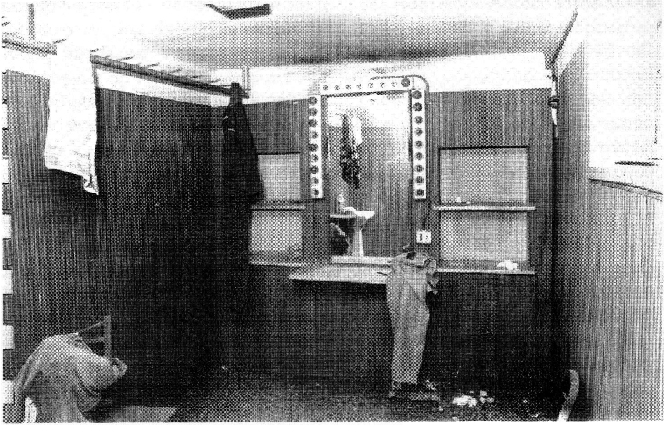
Fig. 3. Situación de los camerinos de primera figura antes de la rehabilitación. 1985.
