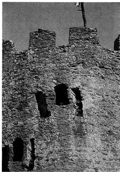
Fig. 14. Vallferosa. Castillo. Torre. Exterior. Zona oeste. Detalle de uno de los cadalsos de la serie superior.
