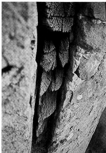
Fig. 15. Vallferosa. Castillo. Torre. Exterior. Zona oeste. Cadalso de la serie inferior. Detalle de las vigas de madera alojadas en las cajas laterales situadas a ambos lados del vano del cadalso y que servían para protegerlo.
