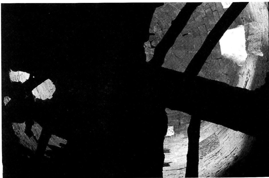
Fig. 22. Vallferosa. Castillo. Torre. Interior. Cúpula perteneciente a la fase románica del siglo XI construida sobre la planta superior.
