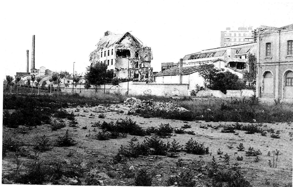
Fig. 5. La Maquinista en fase de derribo, agosto de 1998. (Foto: Eduardo Laborda).
