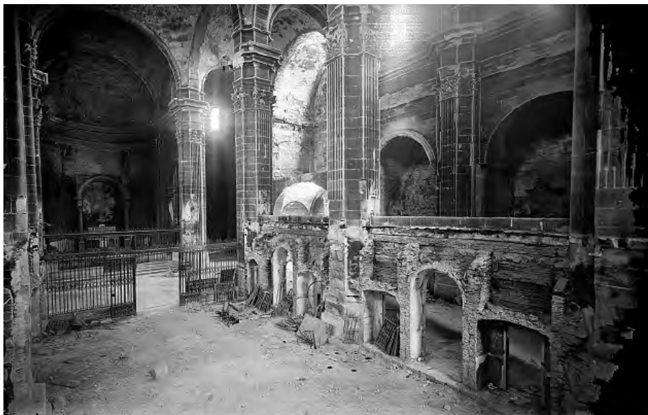
Fig. 7. Estado del interior de la Catedral de Lleida tras el incendio del 24 de agosto de 1936, donde se aprecia la total destrucción del coro, así como el estado de los muros y columnas (Archivo Capitular de Lleida).
