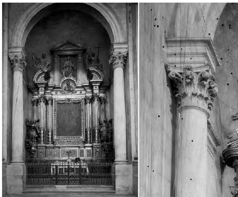
Fig. 4. Vista y detalle de una de las capillas laterales de la Catedral Nueva de Lleida. Flanquean el acceso de cada una de ellas dos columnas con capiteles redondos de orden corintio, labrados por Seller (Institut d'Art Hispànic de Barcelona).
