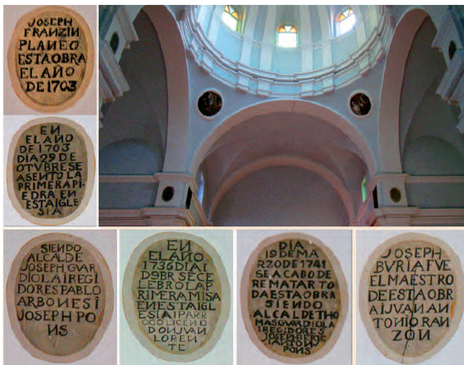
Fig. 12. Vista de la cúpula de la iglesia de Massalcoreig, en cuya base se conservan seis tondos con la información sobre la edificación del templo y sus autores. Fotografías: Josep Maria Vallès.
