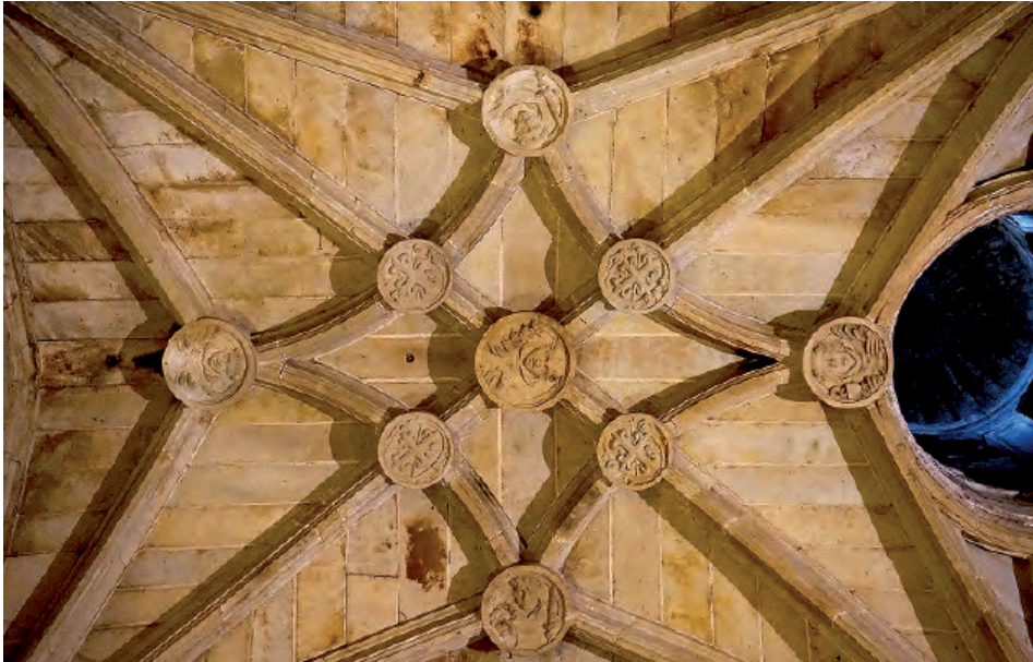
Fig. 6. Detalle de las claves del primer tramo de la bóveda de la capilla de San Pedro Mártir. Fotografía: el autor.
