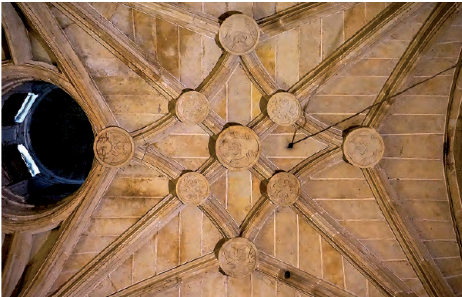
Fig. 7. Detalle de las claves del segundo tramo de la bóveda de la capilla de San Pedro Mártir. Fotografía: el autor.
