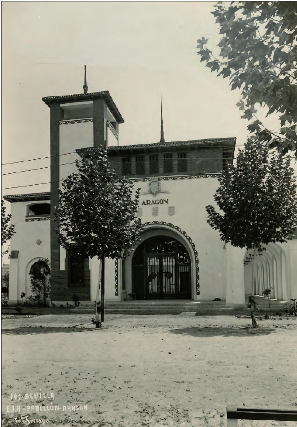
Fig. 1. Vista de la fachada principal del pabellón de Aragón en la Exposición Iberoamericana de Sevilla de 1929. Fuente: A.D.P.Z.
