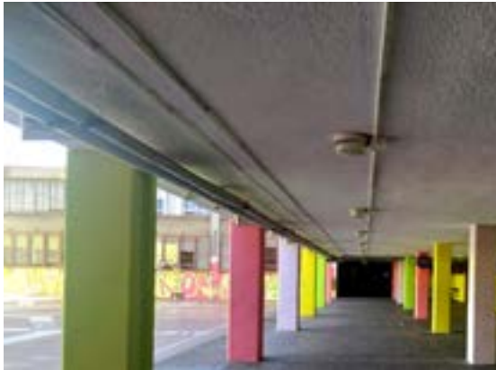
Fachada del patio exterior y taller de bicicletas.
