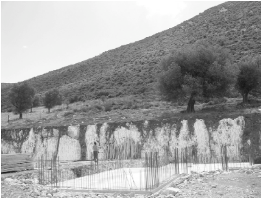
Foto 4. Frente de corrosión kárstica penetrando a través de la red de fracturación de las formaciones marmóreas del polje de Almyopotamos.
