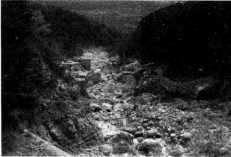
Fotografía 3.- Vista general del sector superior del barranco de Arás tras la riada. Apréciase la desaparición casi total de los muros laterales y transversales de la canalización, y la gran cantidad de materiales morrénicos y coluviales arrastrados y removidos por el flujo.
