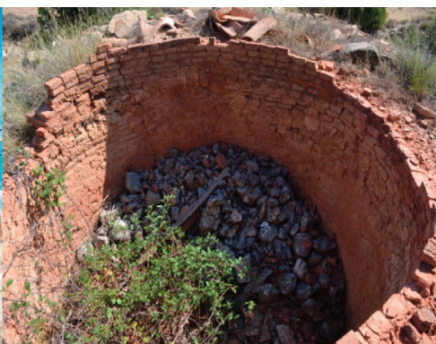
Figura 18. Antiguo horno de tejas en la fábrica Las Golondrinas en Cabra de Mora.
