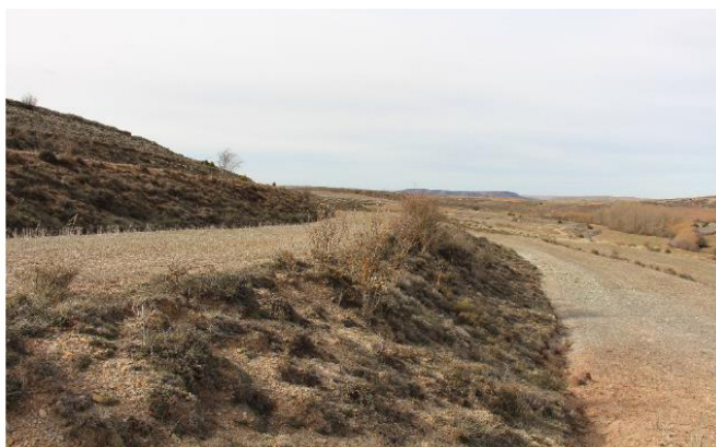
Figura 6. Ejemplo de bancales con talud vegetado.
