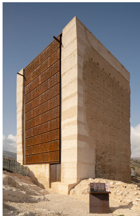
[16] XIXONA. CASTILLO, TORRE GROSSA RESTAURADA Y REPOSICIÓN DEL MURO FALTANTE CON CHAPA DE ACERO CORTEN. EN LA BASE SE ENCUENTRA LA HILADA DE ORIGEN. FOTO: DOALCO.
