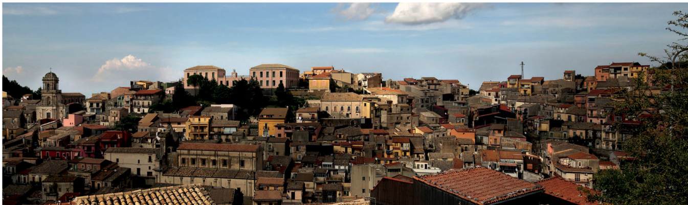
[13] CASA PAPPALARDO: IL TETTO.
