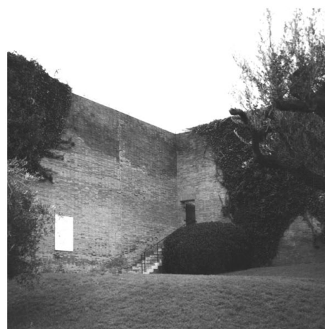
[11] SACRARIO DI GUERRA A MOTTA SANT'ANASTASIA: SCALA D'INGRESSO ALLE KAMMERN ANTE GLI INTERVENTI DI RESTAURO DEL 2002. [FOTO ARCHIVIO V.D.K.].
