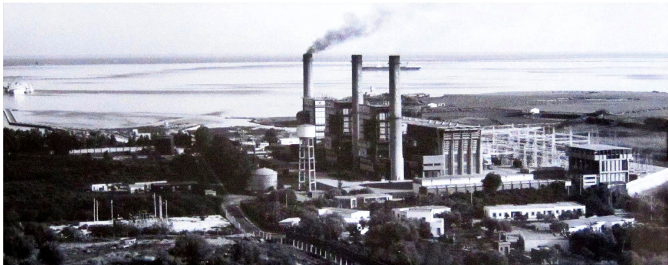
[1] VISTA COMPLESSIVA DA NORD-OVEST DELLA CENTRALE TERMOELETTRICA DI AUGUSTA IN UNA FOTO DEGLI ANNI '50.
