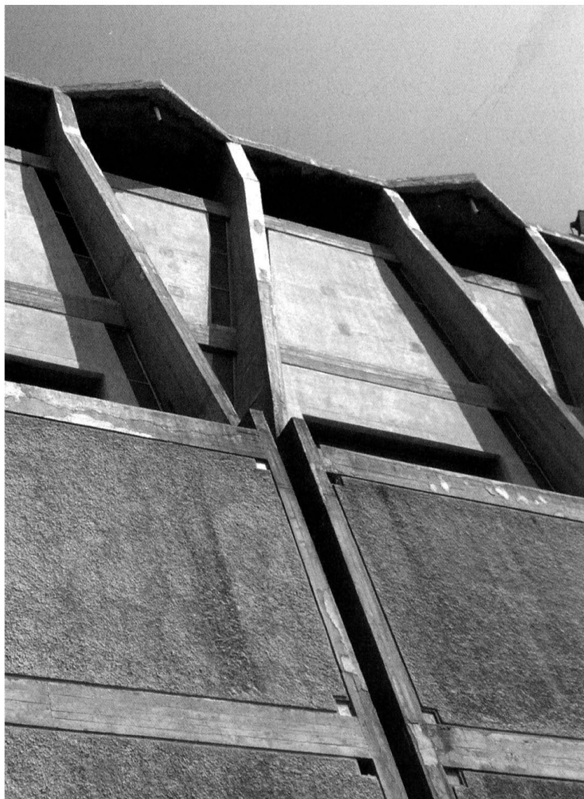
[6] LA CENTRALE TERMOELETTRICA DI AUGUSTA, DETTAGLIO DELLE "FORCELLE" STRUTTRALI.
