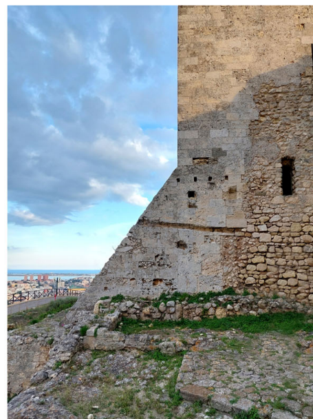
[6] CASTELLO DI SAN MICHELE A CAGLIARI. DETTAGLIO DELLA MURATURA A SCARPA AGGIUNTA AL PRECEDENTE VOLUME DI TORRE, LAVORATA IN BUGNATO SUI LATI ESTERNI (FOTO MARCO CADINU).
