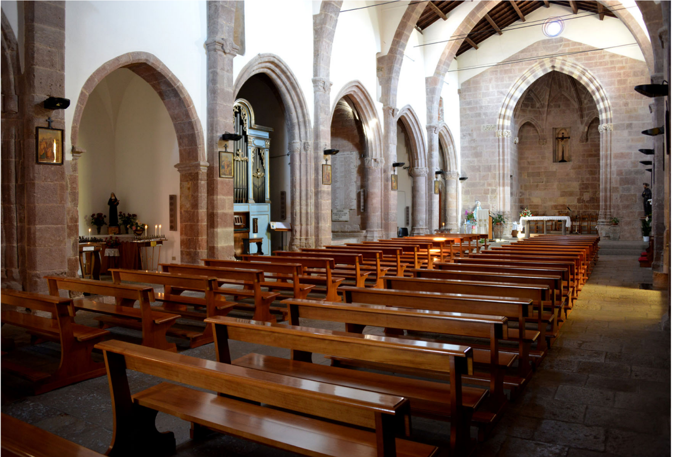
[9] CHIESA DI SAN FRANCESCO DI IGLESIAS. A SEGUITO DELLA SOSTITUZIONE DEI FRANCESCANI TOSCANI CON I CORRISPONDENTI IBERICI LA CHIESA VIENE RISTRUTTURATA CON UN'AMPIA AULA SORRETTA DA ARCHI DIAFRAMMA (FOTO MARCO CADINU).
