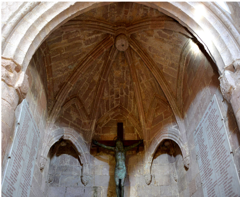
[10] CAPPELLA DEL CROCIFISSO NELLA CHIESA DI SAN FRANCESCO DI IGLESIAS, CON COPERTURA A SPICCHI COSTOLONATI, CHIUSA IN ALTO DA UNA GEMMA SULLA CHIAVE DI VOLTA (FOTO MARCO CADINU).
