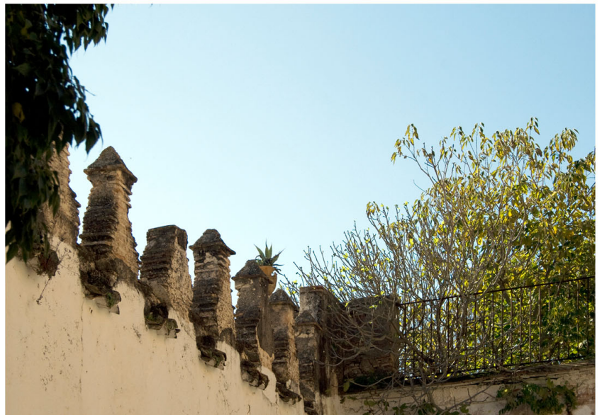
[07] SAN JERÓNIMO DE COTALBA, DETALLE DE LAS ALMENAS SOBRE LOS MUROS DEL CUERPO LATERAL DE LA PLAZA DE ACCESO. (R. PERELLÓ).
