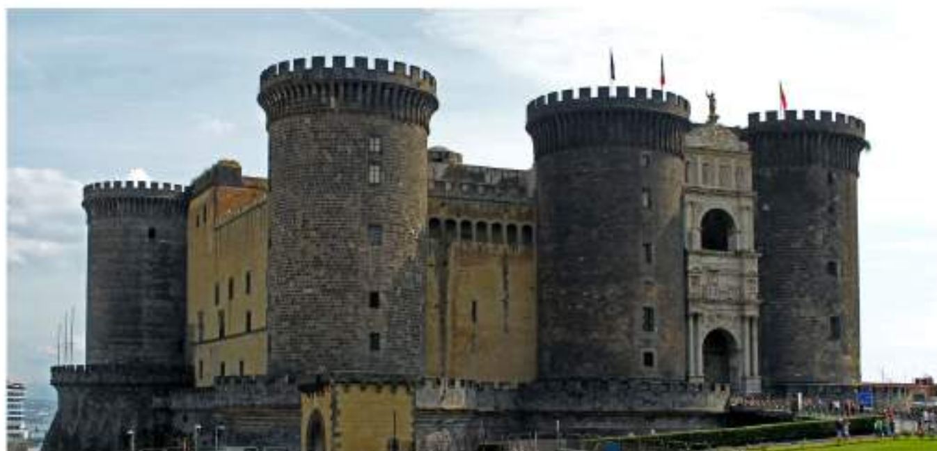
[11] CASTELNUOVO, NÁPOLES. CONSTRUIDO POR CARLOS DE ANJOU HACIA 1266 Y RECONSTRUIDO EN 1473 POR ALFONSO EL MAGNÁNIMO DE ARAGÓN.
