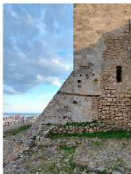
85) CASTELLO DI SAN MICHELE A CAGLIARI. DETTAGLIO DELLA MURATURA A SCARPA AGGIUNTA AL PRECEDENTE VOLUME DI TORRE, LAVORATA IN BUGNATO SUI LATI ESTERNI (FOTO MARCO CADRIU).
