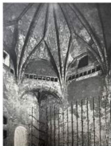
[7] NAPOLI, CASTEL NUOVO, GRAN SALA, INTRADOSSO DELLA COPERTURA, INNesto DELL'IMPOSTA OTTAGONALE OTTENUTA DAGLI ARCHETTI PENSILI E DAGLI ARCHETTI PENSILI CON VOLTE A SPIGOLO, DOPO L'INCENDIO DEL 1918 (R. FLANGERI, CASTEL NUOVO, CIT., P. 70).
