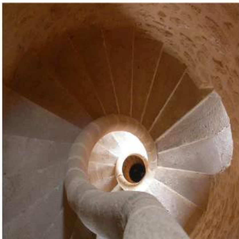
[7] CASTELAMMARE, CASTELLO ALLIATA, DETAGLIO DELLA SCALA A CHIOCCOLA CHE PORTA ALLA TERRAZZA, DEL TIPO CARACOL DE MALLORCA.
