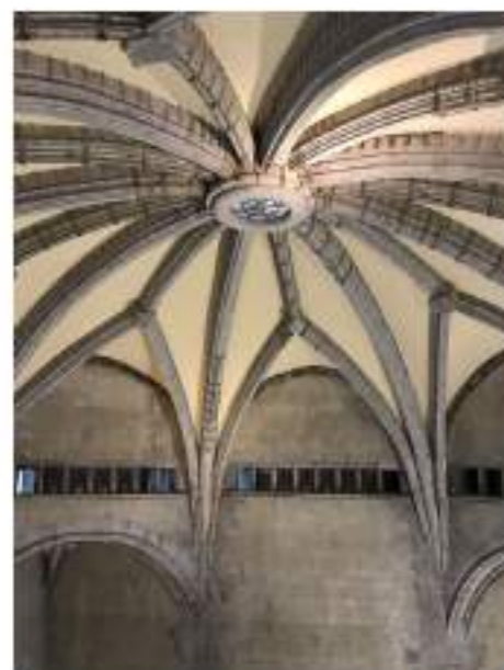
[9] NAPOLI, CASTEL NUOVO, GRAN SALA, INNESCO DELLA COPERTURA E BALLATOI (FOTO DELL'AUTRICE, 2019).
