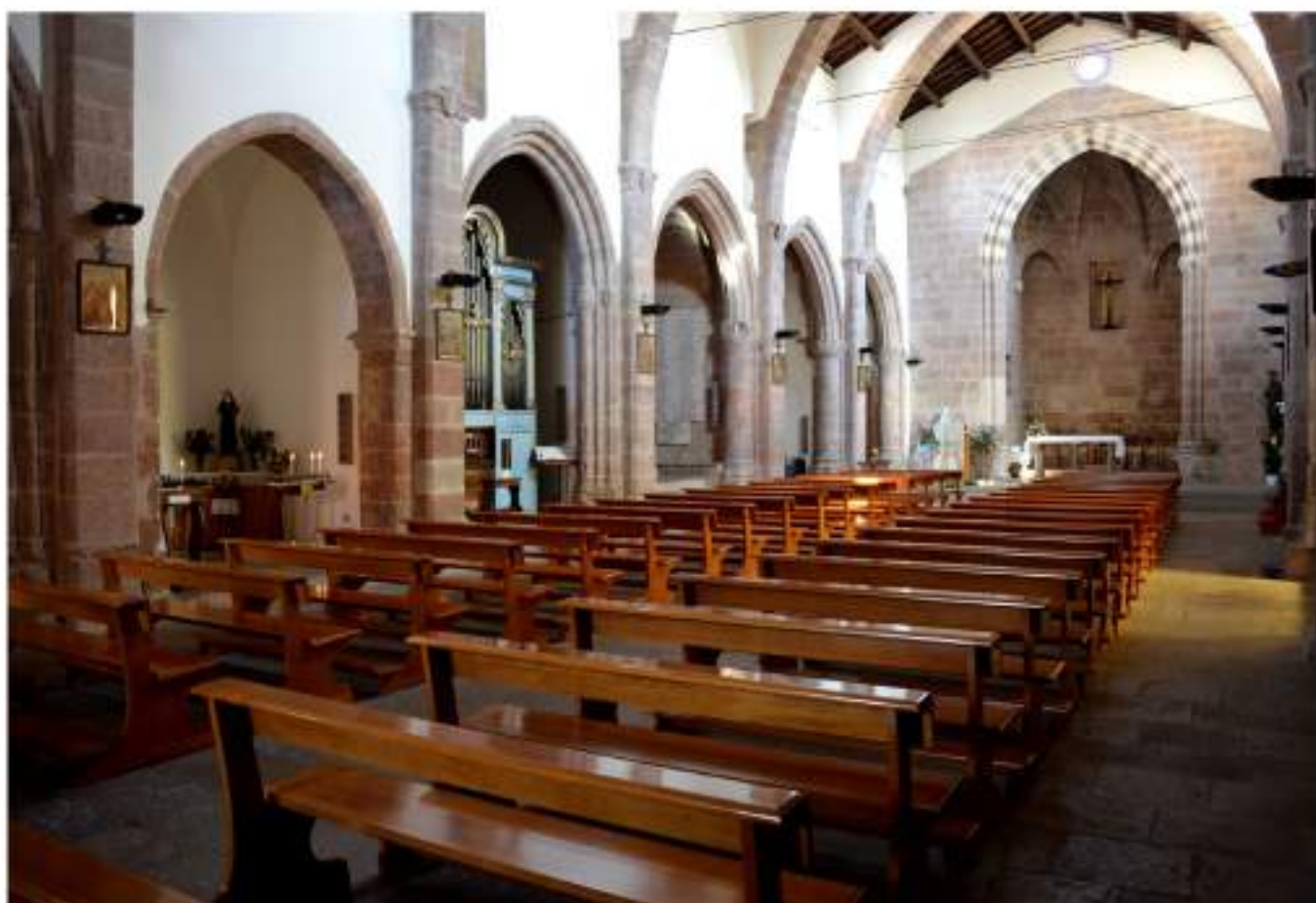
[9] CHIESA DI SAN FRANCESCO DI IGLESIAS. A SEGUITO DELLA SOSTITUZIONE DEI FRANCESCANI TOSCANI CON I CORRISPONDENTI IBERICI LA CHIESA VIENE RISTRUTTURATA CON UN'AMPIA AULA SORRETTA DA ARCHI DI AFRAMMA (FOTO MARCO CADINI).
