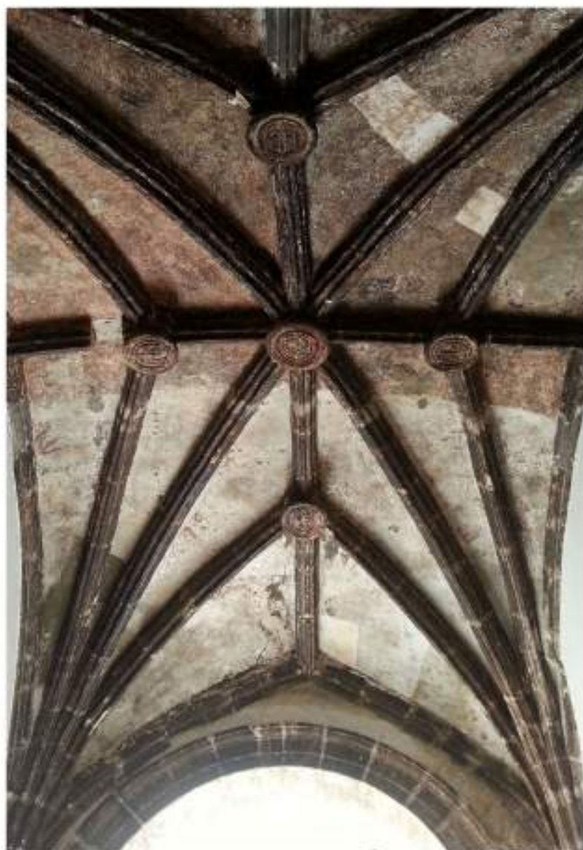
[10] PALERMO. PALAZZO FINIA, VOLTA A CINQUE CHIAVI A COPERTURA DELL'ATRIO D'INGRESSO
