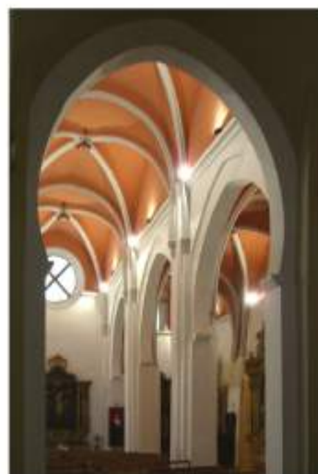
[24-25] 24. SAN ANDRÉS DE CALATAYUD, SECCIÓN DE LA IGLESIA ACTUA, DIBUJO DE J. PEÑA; 25. INTERIOR DE LA IGLESIA Y MEZQUITA (FOTOGRAFÍA DE J. PEÑA): EN BLANCO, NAVE S. XI; EN ROJO, BÓVEDAS GÓTICAS S. XV.
