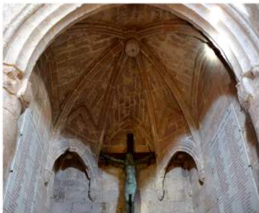
[10] CAPPELLA DEL CROCFISSO NELLA CHIESA DI SAN FRANCESCO DI IGLESIAS, CON COPERTURA A SPICCHI COSTOLONATI, CHIUSA IN ALTO DA UNA GEMMA SULLA CHIAVE DI VOLTA (FOTO MARCO CADRIU).
