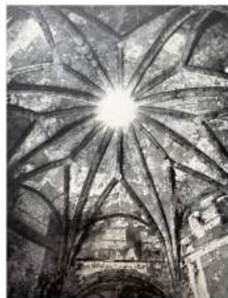
[12] NAPOLI, CASTEL NUOVO, GRAN SALA, INTRADOSSO DELLA COPERTURA DOPO L'INCENDIO DEL 1918, FOTO DELLA SOPRINTENDENZA D'ARTE MEDIOEVALE E MODERNA (I. FILANGIERI, CASTEL NUOVO, OT., P. 69).
