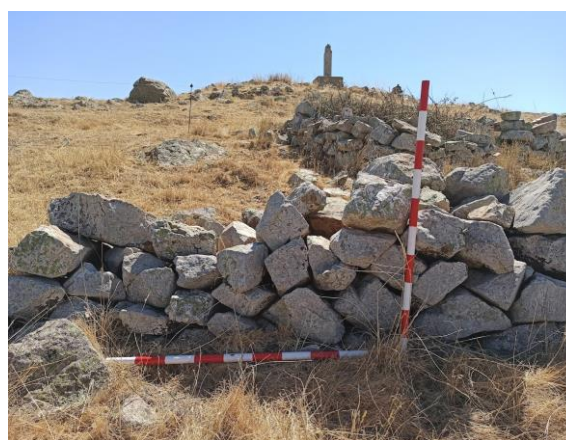
Figura 15. Sistemas constructivos Sup.: estructura interior; Inf.: muro perimetral.
