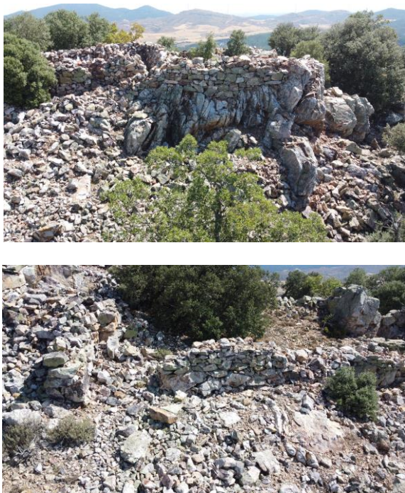
Figura 4. Detalle del muro y del acceso este del fortín.
