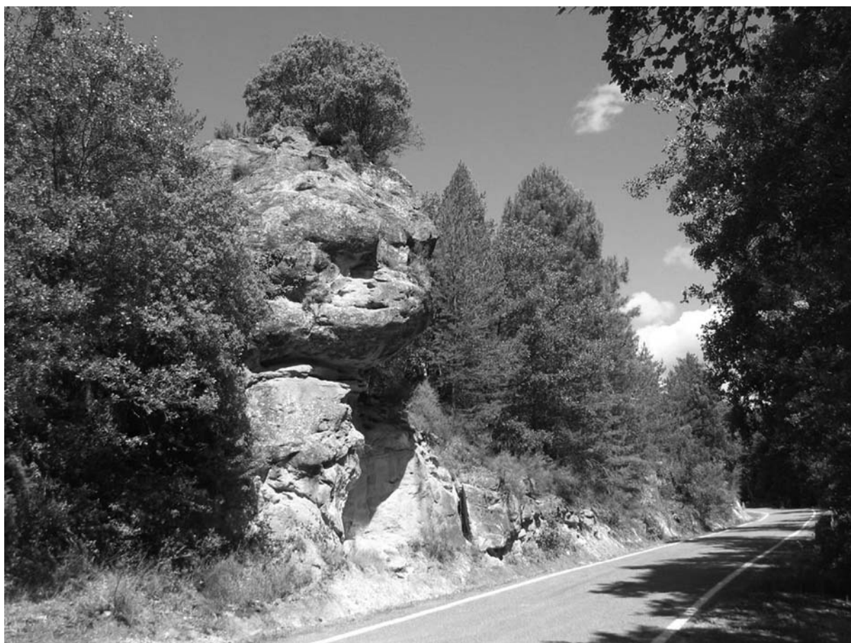
Figura 6. Vista del roquedo que alberga el abrigo de Valcervera y su situación sobre la carretera, visto desde el Sur.
