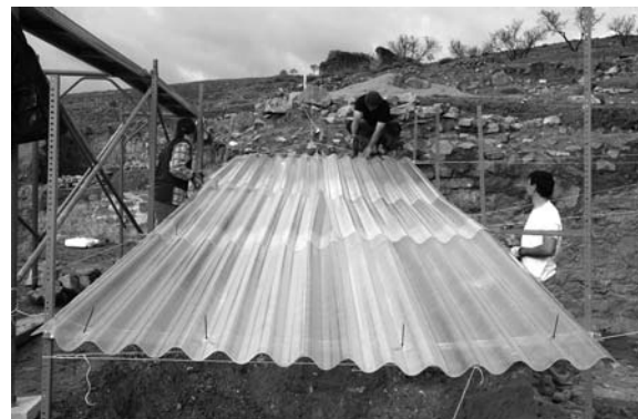
Figura 23. Instalación de la cubierta desmontable sobre el lalario.
