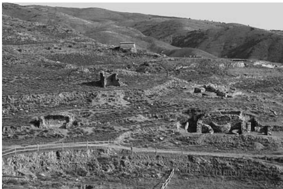
Figura 1. Vista General de la zona de actuación. En primer término la Casa del Ninfeo en el que se aprecian las piletas del juego de agua. Al fondo el edificio indeterminado denominado C.IV.
