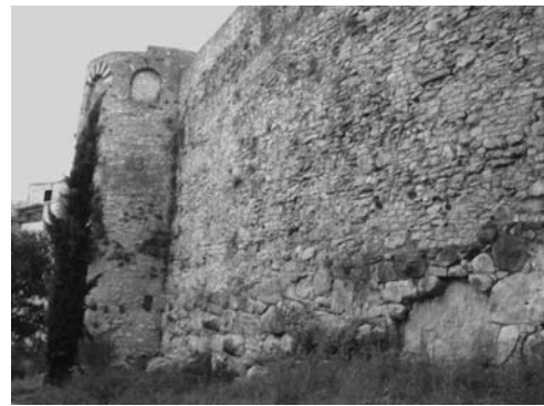
Lámina 29. Gerunda : vista general de uno de los tramos de la muralla de Les Àligues, en el sector Sudeste de la ciudad romana, con su zócalo original de aparejo poligonal de la II manera bajo un crecimiento medieval de mampostería. La cronología del zócalo se localiza en el segundo cuarto del siglo I a.e.
