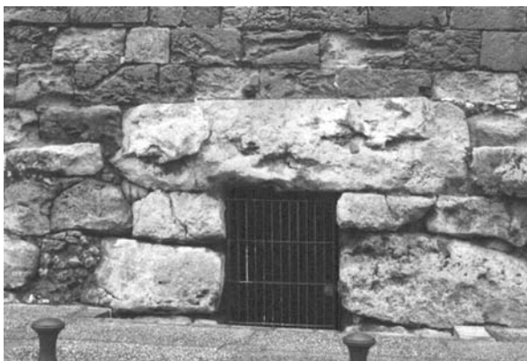
Lámina 64. Tarraco : poterna de la segunda fase de la muralla de la ciudad, datable en el tercer/último cuarto del siglo II a.e., en concreto junto al Portal del Roser. Obsérvese el enorme dintel monolítico en la fábrica poligonal de la II manera del zócalo.
