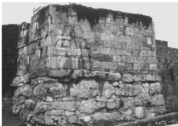
Lámina 55. Tarraco : vista general de la Torre de Minerva/Sant Magí desde el Nordeste, perteneciente a la primera fase de la muralla de la ciudad, datada en torno al 200 a.e. Obsérvese el aparejo poligonal de la II manera del zócalo, de alzado troncocónico, y el aparejo de opus quadratum original del alzado, sólo conservado en la cara Este y la esquina Noreste, con bloques con la cara externa de tendencia cuadrada provistos de almohadillado alisado enmarcado por listel perimetral de notable anchura y con presencia también de orificios tallados para ser elevados por medio de ferrei forfices , tapados posteriormente con unas pequeñas plaquitas de piedra.
