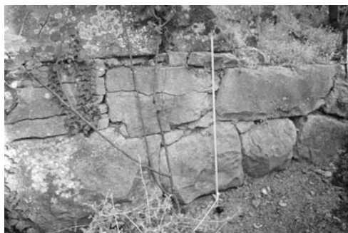
Lámina 25. Gerunda : zócalo de la cara occidental de la Torre Gironella, de aparejo poligonal de la II manera, con crecimiento de opus quadratum y transición de pequeños bloques que regularizan un lecho horizontal para la disposición de los sillares. La cronología de esta se localiza en el segundo cuarto del siglo I a.e.
