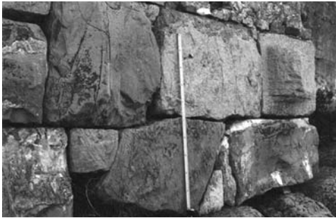
Lámina 40. Saguntum : acrópolis del Castell; basamento poligonal de la II manera de la "Torre de la Plaza", perteneciente a la muralla datada a principios del siglo II a.e. Obsérvese que los bloques, a pesar de su irregularidad, tienden a formar dos hiladas complementadas por cuñas triangulares de calzadura. Uno de los esquinales presenta además almohadillado rústico enmarcado por un listel perimetral de gran anchura.
