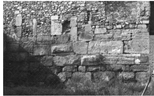
Lámina 41. Saguntum : muro denominado "de Diana" o del "Artemision" (junto a la iglesia de Santa María en la calle Trasaguerio de Sagunto), con aparejo poligonal de la IV manera de porte monumental y cronología dudosa. Obsérvese que los bloques tienden claramente al quadratum y describen hiladas coherentes. Alguno de ellos presenta almohadillado rústico muy prominente enmarcado por un listel perimetral de notable amplitud, características éstas que parecen más propias de obras tempranas adscribibles al siglo II a.e.
