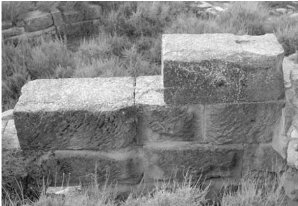
Lámina 70. La Vispesa: muro perimetral Noroeste de opus quadratum . Detalle de la cara interna del mismo, destinada a no ser vista, por lo que la terminación de los bloques es más descuidada. Obsérvese en la cara superior del bloque de la última hilada conservada la marca destinada a las palancas que sirvieron para desplazar horizontalmente los sillares de la hilada superior. La cronología de esta obra puede situarse en la primera mitad o mediados del siglo I a.e.
