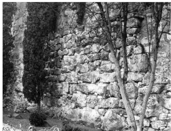
Lámina 50. Tarraco : vista general del paramento externo del tramo de muralla al Oeste de la Torre de Minerva, perteneciente a la primera fase de la misma, datable en torno al 200 a.e. Obsérvese el aparejo poligonal de la II manera con bloques muy irregulares asentados en seco con abundantes cuñas.
