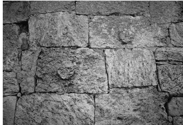
Lámina 33. Olèrdola: cilindros en relieve tallados en dos de los bloques del "Tramo 3", poligonal de la IV manera, de la muralla de la fortaleza, al Oeste de la "Torre IV". La cronología de esta obra se localiza entre finales del siglo II y comienzos del I a.e.
