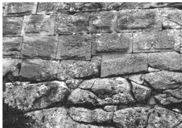
Lámina 60. Tarraco : detalle de uno de los métodos de transición empleados para asentar el alzado de opus quadratum sobre el zócalo poligonal de la II manera en la segunda fase de la muralla de la ciudad, datable en el tercer/último cuarto del siglo II a.e. Este pequeño tramo se localiza en la cortina delimitada por las torres del Arcebisbe y Cabiscol. Obsérvese que en este caso se tallaron los bloques de la primera hilada de sillares de quadratum con formas poligonales, que se asemejan a las de los bloques poligonales del IV manera, con objeto de adaptarse a las irregularidades de los bloques poligonales del zócalo.
