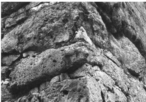
Lámina 57. Tarraco : detalle de la esquina Noreste del basamento de aparejo poligonal de la II manera de la Torre de Minerva/Sant Magí, perteneciente a la primera fase de la muralla de la ciudad, datada en torno al 200 a.e. Obsérvese la presencia de dos caras esculpidas en altorrelieve en uno de los bloques de esquina, en el centro de la imagen.
