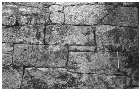
Lámina 30.- Olèrdola: aparejo poligonal de la IV manera del denominado "Tramo 1" de la muralla de la fortaleza, junto a la cara oriental de la "Torre I". Obsérvese la presencia de engastillamientos, cuñas cuadrangulares y llagas oblicuas. La cronología de esta obra se localiza entre finales del siglo II y comienzos del I a.e.
