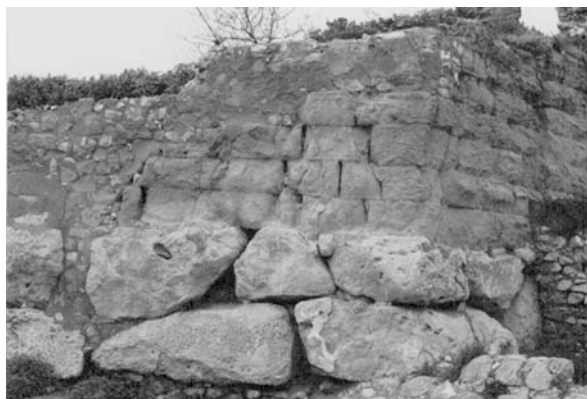
Lámina 59. Tarraco : esquina Noreste de la muralla de la ciudad, perteneciente a la segunda fase de la misma, datable en el tercer/último cuarto del siglo II a.e., concretamente entre los paseos Torroja y Sant Antoni en lo que era el baluarte moderno de Sant Josep. Obsérvese la técnica del zócalo poligonal, con bloques apenas desbastados casi en bruto que incluso podrían ser adscritos a la I manera de Lugli. El alzado se opus quadratum se encuentra muy estropeado en este punto.
