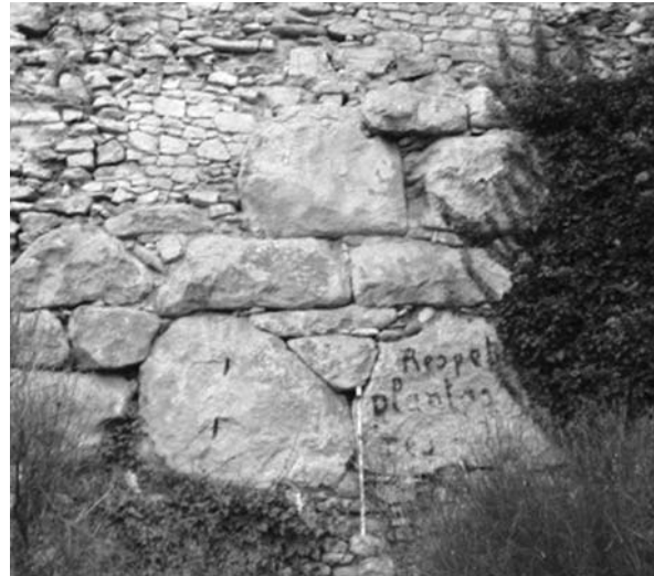
Lámina 28. Gerunda : muralla de Les Àligues, en el sector Sudeste de la ciudad romana. Detalle del zócalo monumental de aparejo poligonal de la II manera, de época fundacional, bajo un crecimiento medieval de mampostería. Obsérvese el tamaño muy irregular de los bloques y las cuñas triangulares y trapezoidales de calzadura. La cronología de este zócalo se localiza en el segundo cuarto del siglo I a.e.
