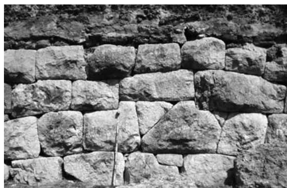
Lámina 8. Emporiae (Ampurias romana): muralla meridional, con zócalo de opus quadratum de la IV manera y crecimiento de opus caementicium . Obsérvese en el basamento de piedra los bloques que tienden a formar cuatro hiladas, el almohadillado rústico sin listel perimetral en este caso, así como las cuñas triangulares y trapezoidales de calzadura. La cronología de esta obra, no del todo clara, tiende a localizarse a principios del siglo I a.e.
