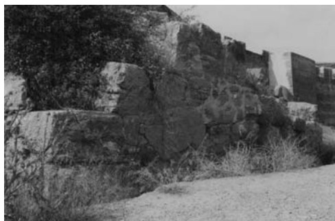
Lámina 37. Saguntum : muralla de la acrópolis del Castell, datada a principios del siglo II a.e. Restos del basamento de la "Torre de de la Plaza de Estudiantes", poligonal de la II manera con esquinales bien trabajados y zapata inferior de base de los muros.
