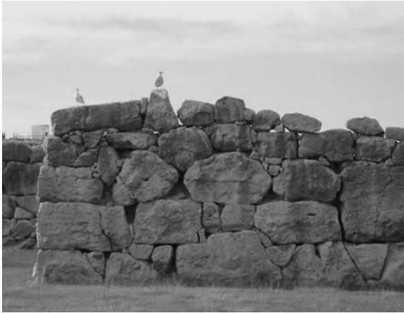
Lámina 19. Emporiae ("Neápolis" de Emporion ): torre occidental de la puerta de la muralla Sur de la ciudad. Aparejo monumental de opus siliceum cercano a la II manera de Lugli. La cronología de esta obra se localiza a mediados del siglo II a.e.
