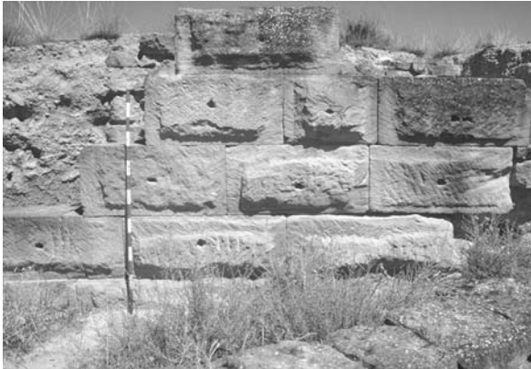
Lámina 66. La Vispesa (1996): muro perimetral Noroeste de opus quadratum , con bloques muy regulares de módulo 0'50/0'55 colocados por medio de ferrei forfices , a juzgar por lo orificios de sus caras mayores, terminados con almohadillado más o menos prominente alisado con labra en espiga o con surcos concéntricos, listel perimetral de notable anchura, así como marcas verticales paralelas en algún caso. La cronología de esta obra puede situarse en la primera mitad o mediados del siglo I a.e.
