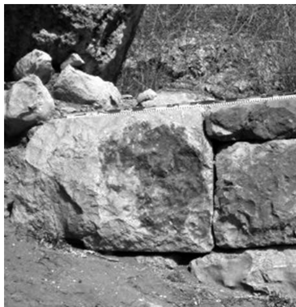
Lámina 16. Emporiae (Ampurias romana): extremo oriental de la muralla Sur, con zócalo poligonal bastante cuidado, pero diferente del resto de este lado meridional, con la presencia de un sillarejo de calzadura con parecida disposición a la de algunos casos en opus quadratum . La cronología de esta obra se localiza a principios del siglo I a.e.
