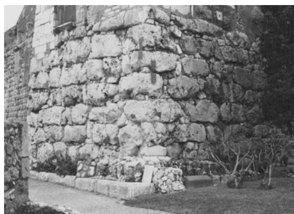
Lámina 52. Tarraco : detalle del basamento poligonal de la II manera de la Torre del Arquebisbe, perteneciente a la primera fase de la muralla de la ciudad, datable en torno al 200 a.e. Obsérvese el aparejo poligonal de la II manera con bloques asentados con abundantes cuñas.
