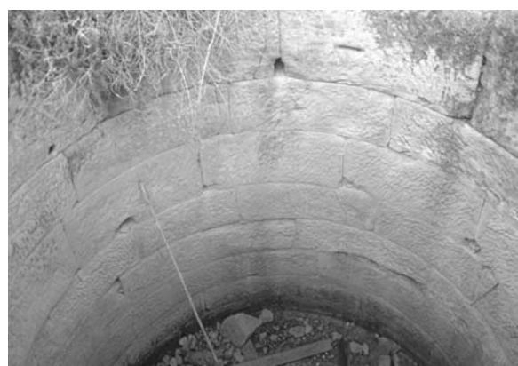
Lámina 69. La Vispesa: gran cisterna con vaso forrado de opus quadratum con sillares provistos de listel perimetral. La cronología de esta obra puede situarse en la primera mitad o mediados del siglo I a.e.
