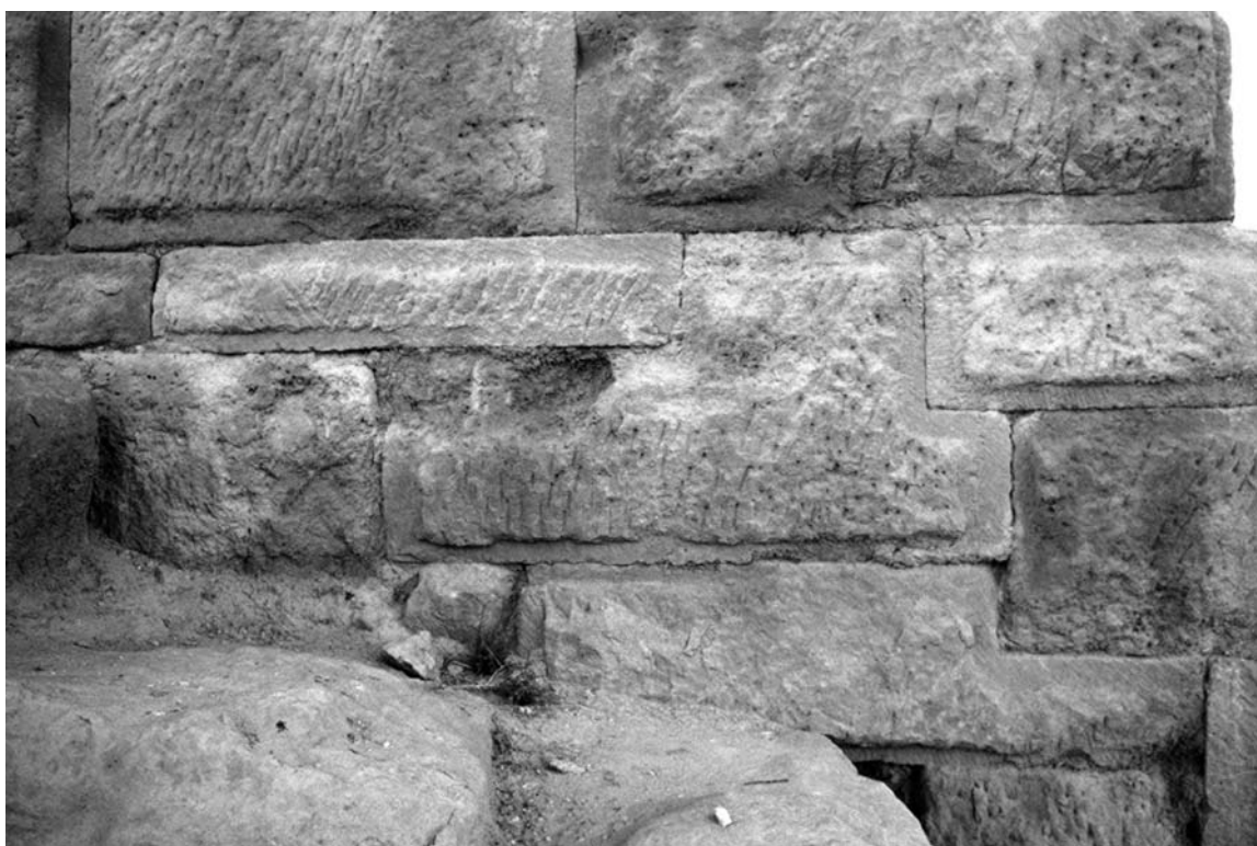
Lámina 6. Contrabía Belaisca : gran muro al Sudeste del Cabezo de las Minas, de cronología incierta que creemos romana republicana; detalle del zócalo de opus quadratum , con bloques terminados con almohadillado alisado de escaso relieve a puntero, listel perimetral y complicados engatillamientos.
