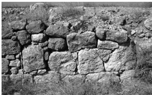
Lámina 13. Emporiae (Ampurias romana) tramo Sur de la muralla oriental de la ciudad, denominada "muralla Robert", de aparejo poligonal de la II manera. La cronología de esta obra, por criterios estratigráficos, se localiza a principios del siglo I a.e.
