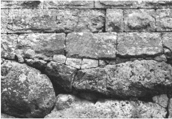
Lámina 61. Tarraco : detalle de uno de los métodos de transición empleados para asentar el alzado de opus quadratum sobre el zócalo poligonal de la II manera en la segunda fase de la muralla de la ciudad, datable en el tercer/último cuarto del siglo II a.e. En este caso se emplean unos pequeños bloques poligonales de calzadura que salvan las irregularidades del zócalo.
