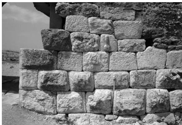
Lámina 9. Emporiae (Ampurias romana): basamento de la muralla Sur. Detalle de la jamba oriental exterior de la puerta meridional de la ciudad, de aparejo poligonal de la IV manera de factura impecable, que tiende al quadratum , con bloques provistos de almohadillado rústico enmarcado por listel perimetral de escasa anchura (5-8 cm). Obsérvese el falo tallado en relieve en la quinta hilada. La cronología de esta obra tiende a localizarse a principios del siglo I a.e.
