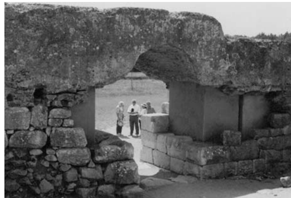
Lámina 12. Emporiae (Ampurias romana): muralla meridional. Detalle del interior de la puerta Sur de la ciudad desde el Norte. Obsérvese el basamento de opus siliceum , muy cuidado de la IV manera en la jamba occidental, como la mayor parte del zócalo de la obra, y mucho más tosco cercano a la II manera de Lugli en la jamba oriental, parecido al empleado en la muralla Este o "Robert" de la fundación romana. Parece evidente que en esta muralla trabajaron simultáneamente al menos dos grupos de constructores, algo muy frecuente en obras, como ésta, de gran envergadura. La cronología de esta obra tiende a localizarse a principios del siglo I a.e.
