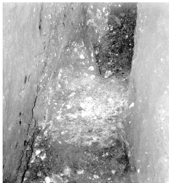
Foto 1a. Cata del vestíbulo. Detalle de cimentación.
