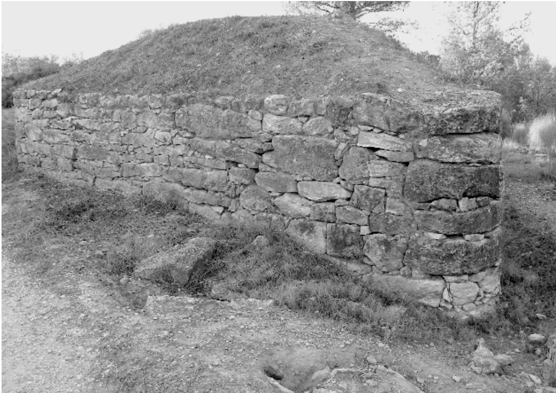
Figure 2. La tour pentagonale Nord vue du sud-est (cliché P. Moret).
