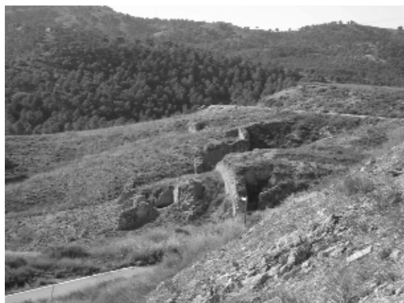
Foto 4. Conjunto estructural en ladera Sur.
