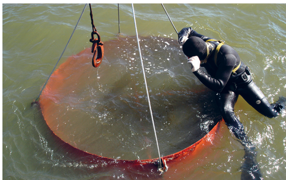
Figura 3. Puerto de Montevideo (ROU) en 2005. Campana para excavación en fondos de lodo. Fot. MMB.
