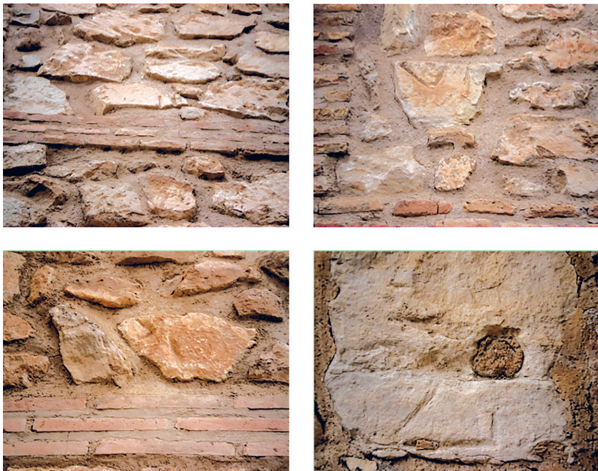
Figura 1. Detalle de algunos de los fragmentos de sillares con marcas epigráficas procedentes de la presa romana empleados en la construcción del muro norte de la Ermita de Ntra Srª de la Fuente en Muel.
