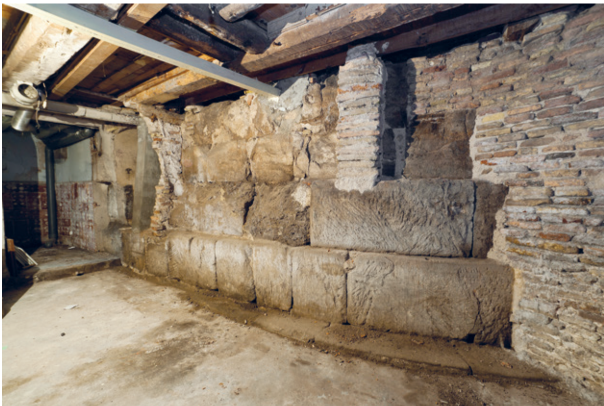
22. Sótano de Coso 147 (antiguo 151). Arranque de la torre sur de la puerta, desde el sudeste.
