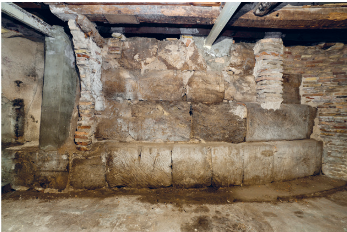
21. Sótano de Coso 147 (antiguo 151). Arranque del lado meridional de la torre sur de la puerta.
