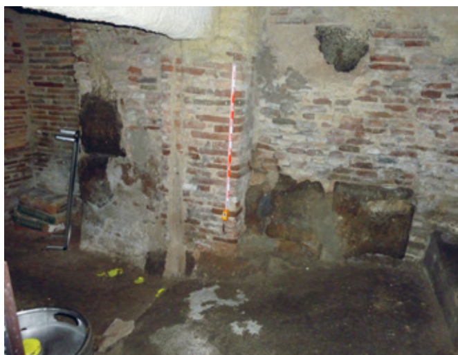
19. Sótano de Coso 147 (antiguo 153). Paramento sur.
