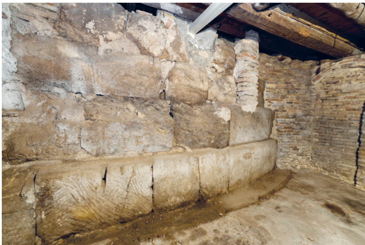
23. Sótano de Coso 147 (antiguo 151). Inicio de la curva de la torre sur de la puerta, desde el oeste.
