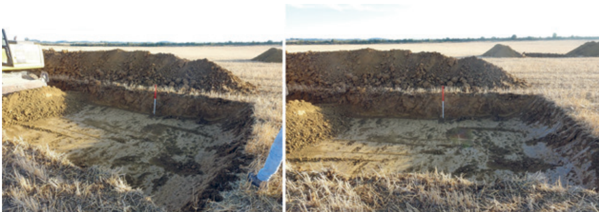
Fig. 12 Cata en cuadrante con coordenadas: a. 674.103; 4.667.352, b. 674.099; 4.667.350, c. 674.092; 4.667.360, d. 674.096; 4.667.362.
