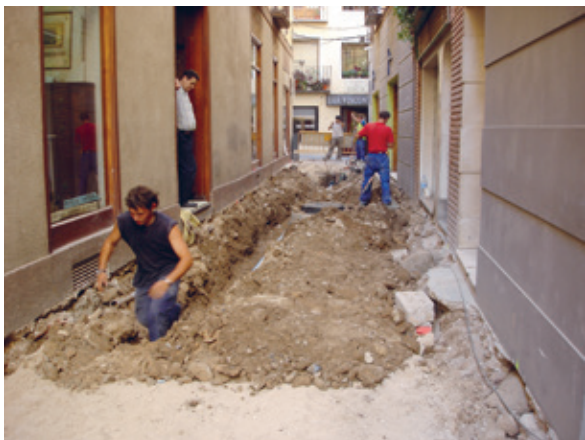
Figura 2. Fotografía de los trabajos de saneamiento de la Calle Travesía Juan Navarro.
