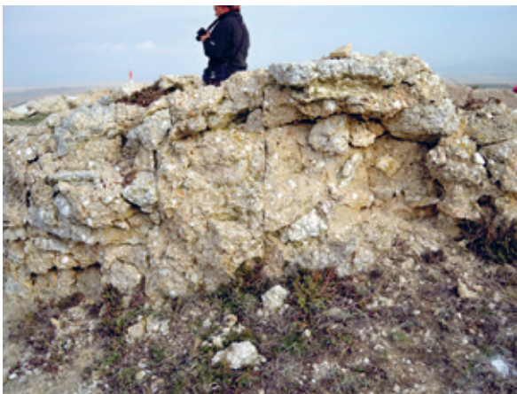
Figura 10. Líneas de encofrado al exterior de la torre (parte sur).
