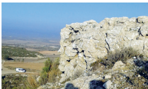
Figura 5. Detalle de la torre antes de la intervención.
