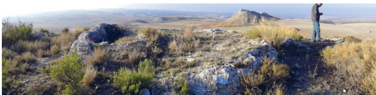
Figura 4. Panorámica de la torre antes de la intervención.
