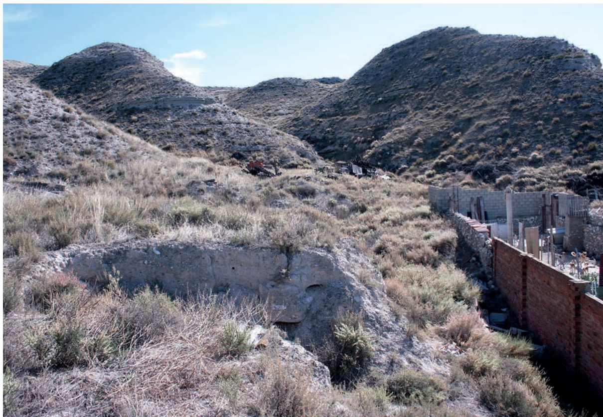
Figura 2. Detalle del rellano de la ladera cortado por una cabaña semisubterránea y talud en cuya base aparecían los restos de alabastro.
