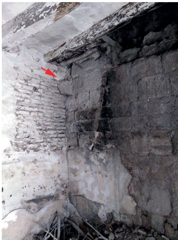
Figura 19. Vivienda 2. Posible ménsula y chimenea original de la casa fuerte.
