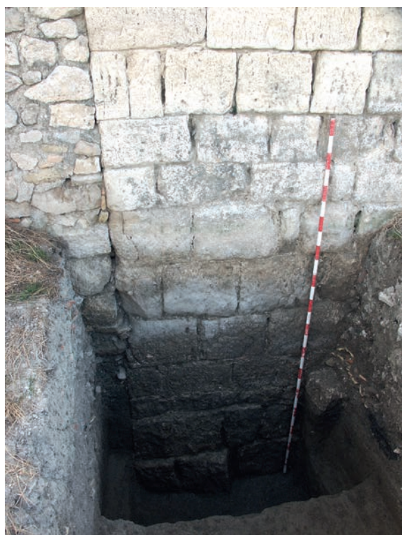
Figura 6. Vista final de la cata 2, base de la cimentación.
