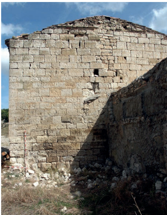
Figura 15. Lateral Oeste de la casa fuerte.
