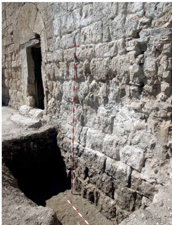
Figura 7. Vista final de la tercera cata, cimentación sobre roca natural.
