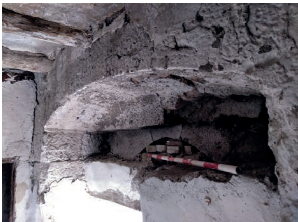
Figura 17. Vista del arco interior del acceso original a la casa fuerte.
