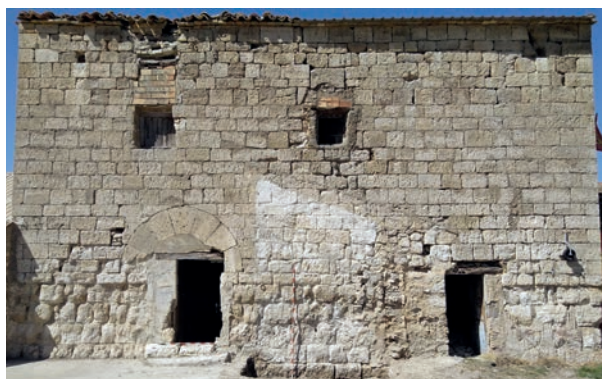
Figura 5. Vista general de la fachada principal, completamente despejada.
