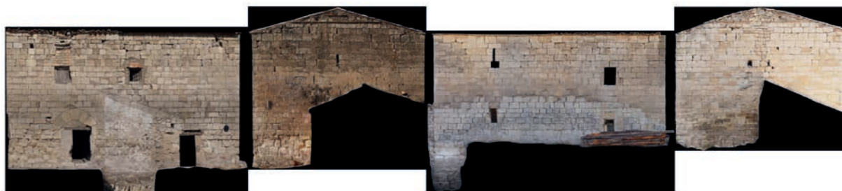
Figura 23. Orto-imagen de los alzados de la casa fuerte de La Gabardilla.
