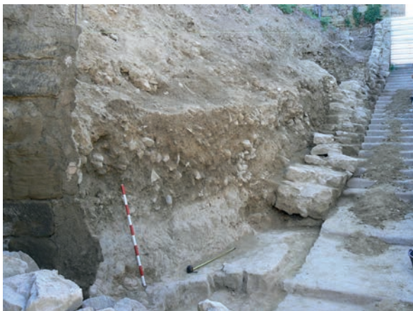
Figura 17. Vista desde el NO de la fase moderna del muro desplomado una vez saneado del derrumbe.
