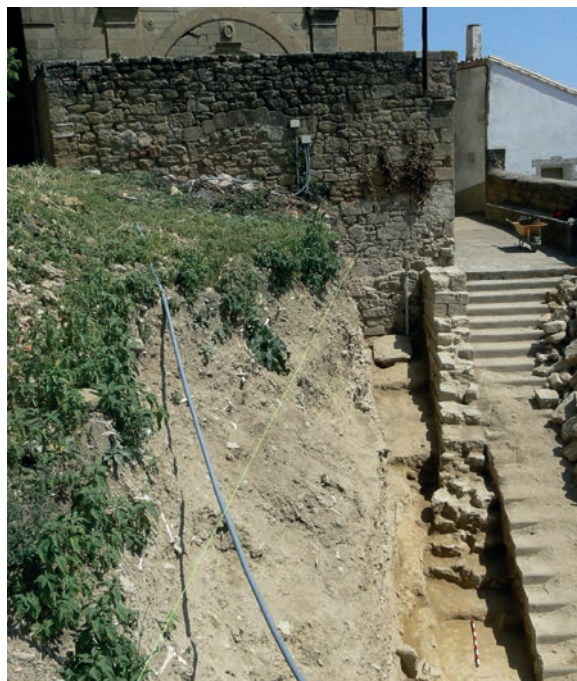
Figura 20. Vista desde el oeste de parte de la excavación una vez terminada. Sobre ésta y de frente, se aprecia el lienzo completo del muro SE (ue.38) y en su centro, el vano de acceso al camposanto clausurado.
