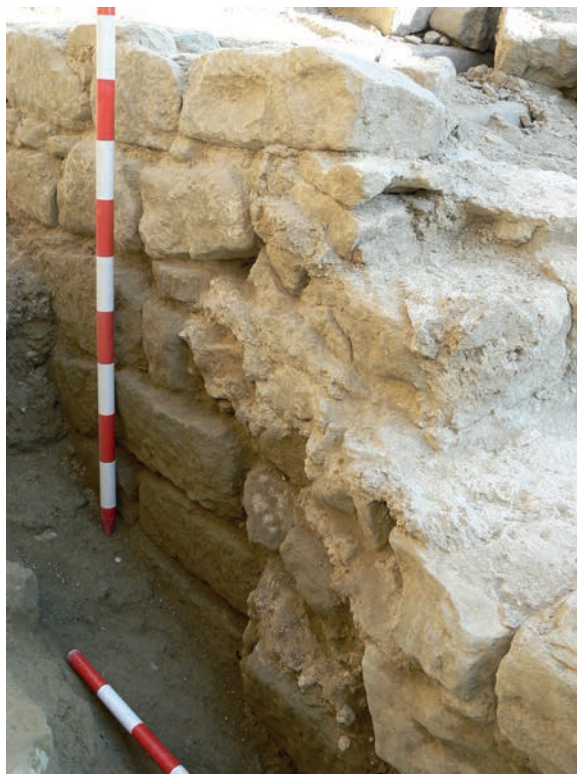
Figura 19. Detalle de las dos fábricas en el punto en que el muro medieval de sillarejo (izquierda de la foto) recibe la estructura moderna de mampostería y cal (derecha de la foto).
