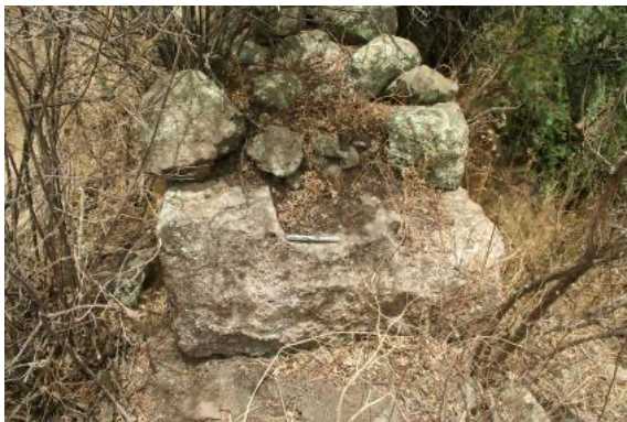
Figura 9. Fragmento segunda etapa constructiva. (Imag. FGV)
