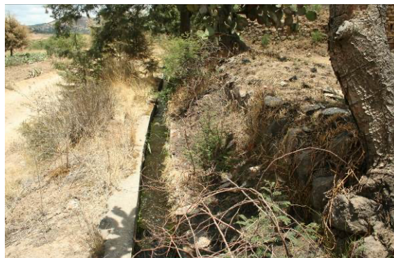
Figura 13. Canal contemporáneo fabricado con hormigón y que corre paralelamente al prehispánico cuya estructura de mampostería es a base de roca y lodo (margen derecha). (Imag. FGV.)
