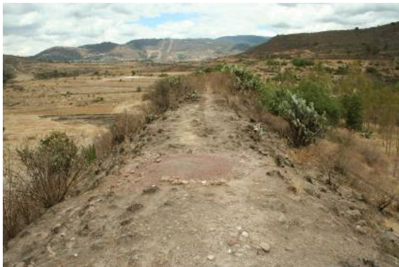
Figura 8. Parte superior del terraplén sector poniente. (Imag. FGV)
