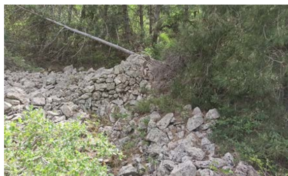
Figura 19. Restos de las estructuras del puesto de observación "Dehesa alta".
