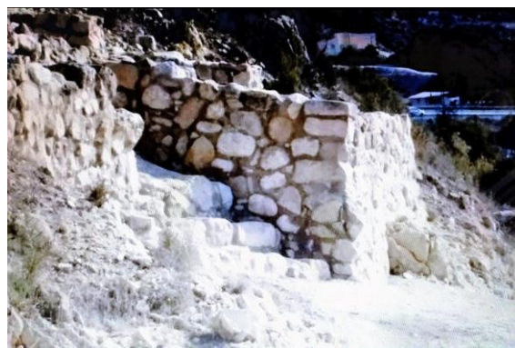
Figura 10. Poterna de acceso en la muralla inferior junto al torreón en El Monastil (Imag. A.M. Poveda)
