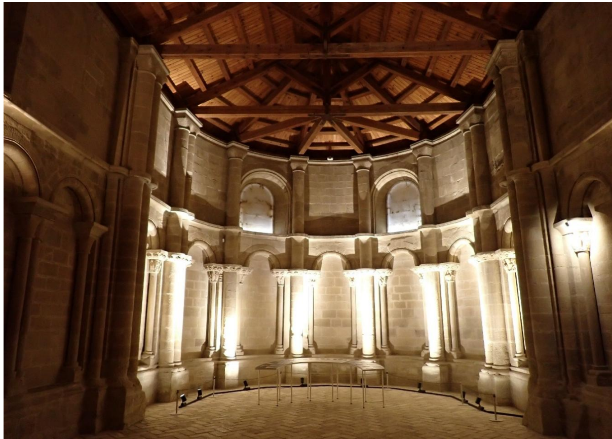
Figura 1. Vista general del ábside con la zona de capiteles historiados en la sala de Doña Petronila. (Museo de Huesca)
