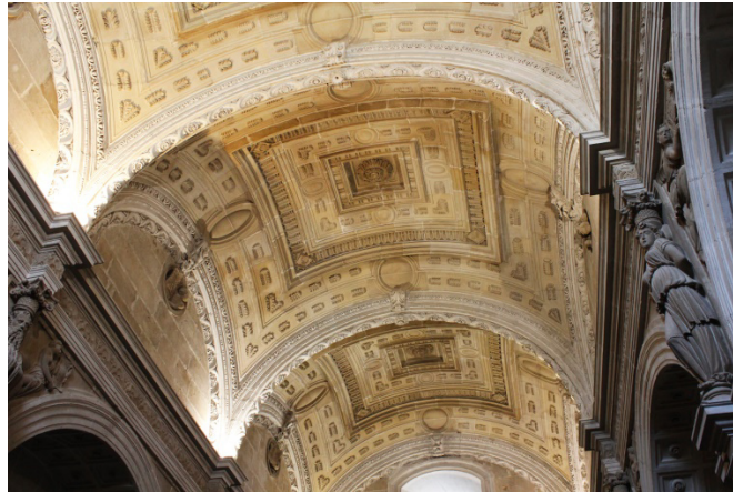
Fig. 1. «Capillas perlongadas por hiladas cuadradas». Sacristía de la Sacra capilla del Salvador. Úbeda. Andrés de Vandelvira. 1540.
