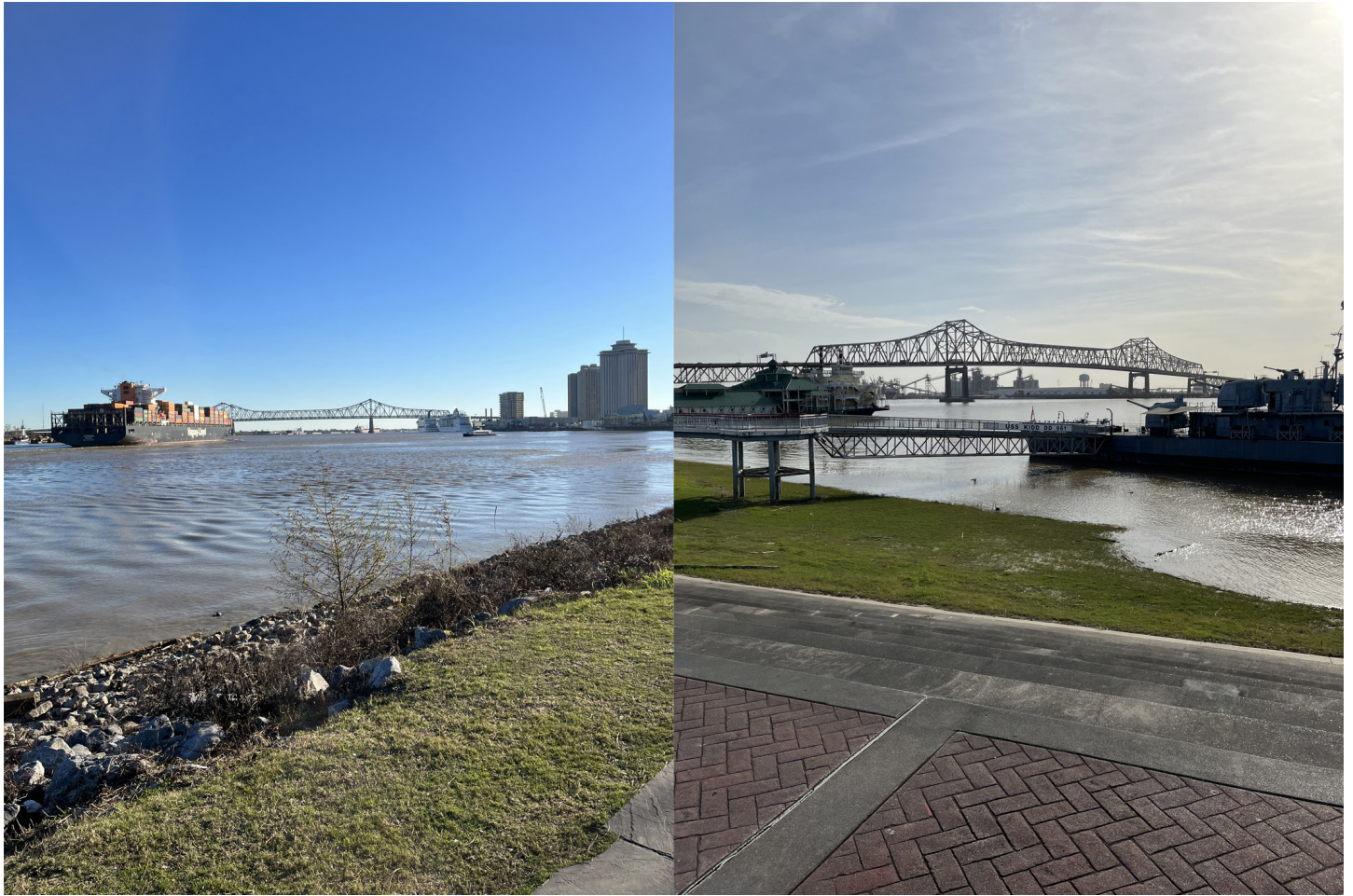
Figura 7. Imágenes de la cara del dique hacia el río Mississippi a su paso por el núcleo urbano de New Orleans y Baton Rouge.
