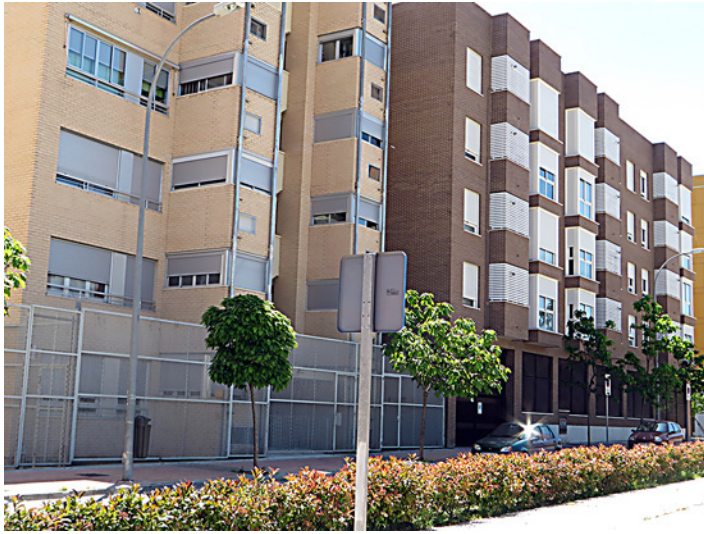
[Fig. 13] Fachada al Ecobulevar de las 2 promociones de la 3ª manzana a la derecha: soportales de uso privado y vallas en planta baja.
