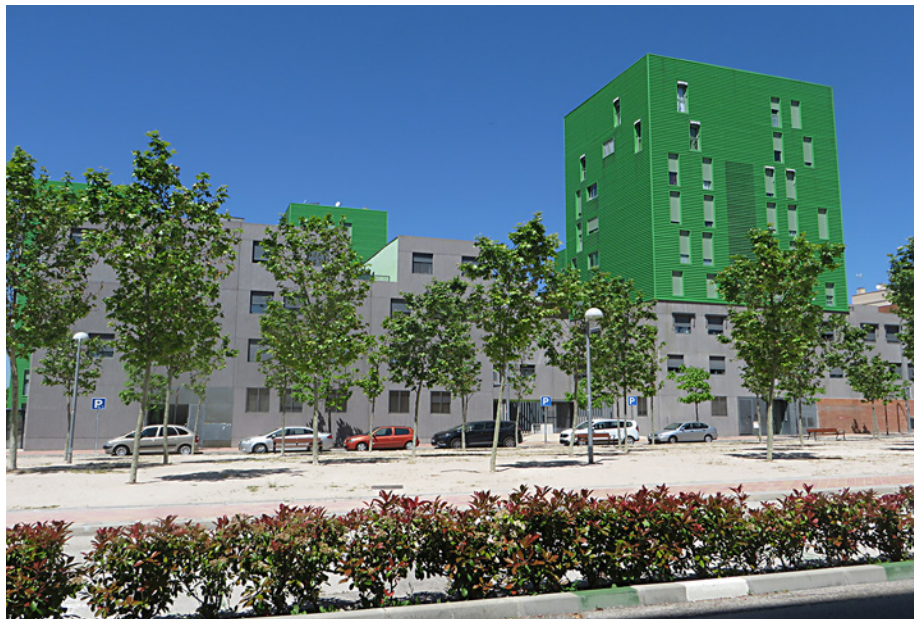
[Fig. 20] Fachada al Ecobulevar de la manzana nº 2.
