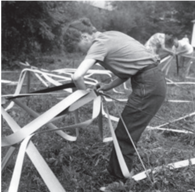
[Fig. 7] Elaine de Kooning colaborando en la construcción de la cúpula geodésica en el BMC, 1948. Fuente: https://black-mountainresearch.com/photography/elaine_de_kooning_and_buckminster_fullers_venetian_blind_strip_dome_1948_summer_session_in_the_arts_black_mountain_college/ Fotografía de Trude Guermonprez (consultado el 19 de enero de 2017).
