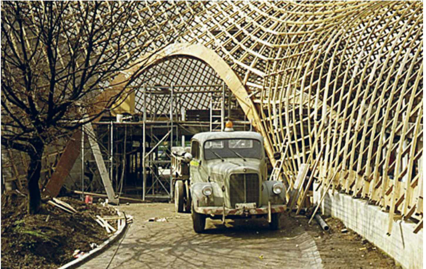
[Fig. 15] Imágenes de la construcción.
