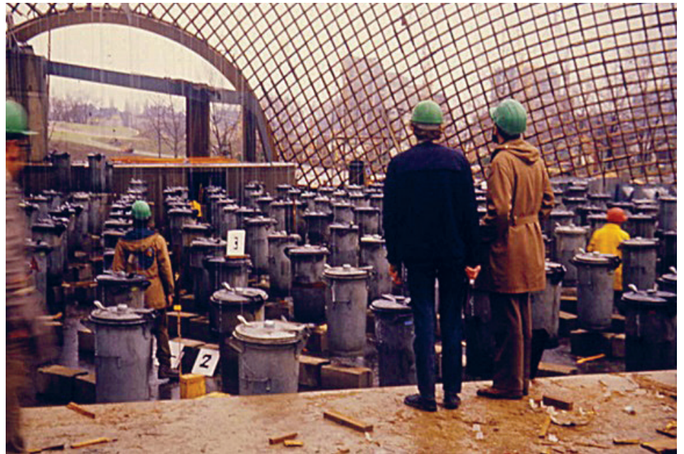
[Fig. 17] Prueba de carga con contenedores de basura llenos de agua.
