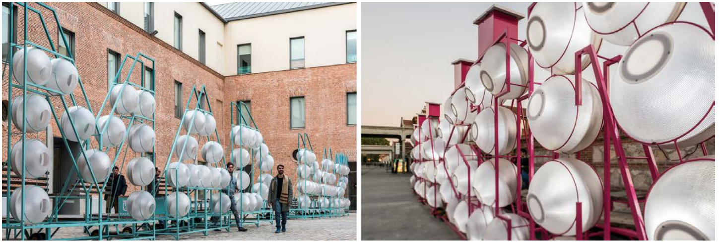
[Fig. 6] Prototipo para el pabellón CONAMA del Ayuntamiento de Madrid 2016. (izq). Copy-Paste-Upgrade para Imagina Madrid 2017. Reducción de la escala para permitir el transporte sin desmontaje, e incorporación de iluminación y alimentación solar. Eeestudio+Zuloark+D.Cárdenas+Mecedorama. Fuente: Eeestudio+Zuloark+Lys Villalba+David Cárdenas. Proyectos Pabellón Conama e Imagina, para Ayuntamiento de Madrid. Fotografías de Javier de Paz García. 2017-2018.
