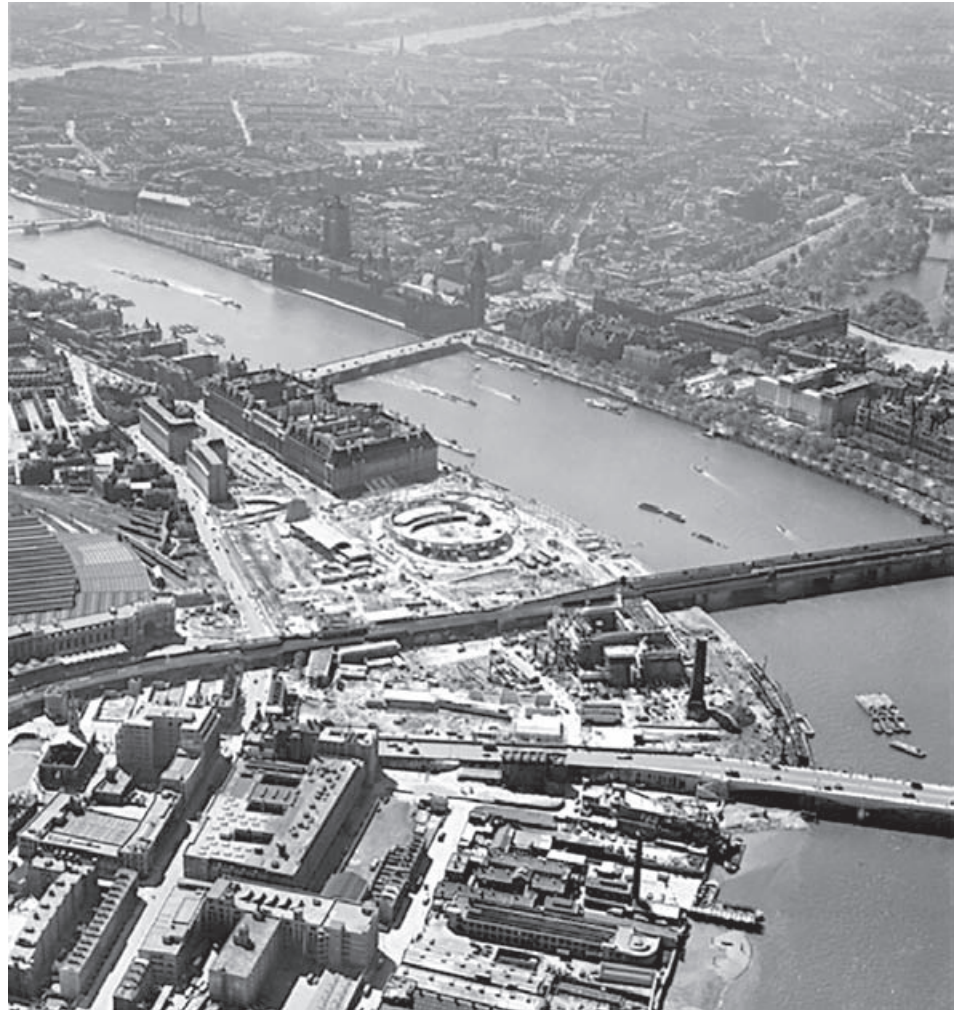
[Fig.2]. El recinto de la South Bank Exhibition en construcción. Fuente: https://www.britain-fromabove.org.uk/en
