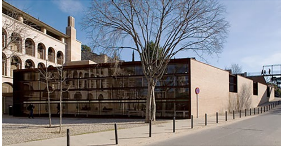
Figura 6. La ampliación de la biblioteca del campus de nueva construcción y la urbanización de la plaza Ferrater Mora, con su actitud de ir más allá, consiguen aportar una nueva luz urbana a momentos oscuros del espacio público del casco antiguo. Supera la dualidad entre proyecto arquitectónico y urbano, la arquitectura crea un espacio público que consigue ser un “lugar monumental”. EL vidrio conecta contemporáneamente materialidades pasadas y futuras. 18 © Joan del Pozo © Archivo histórico COAC.
