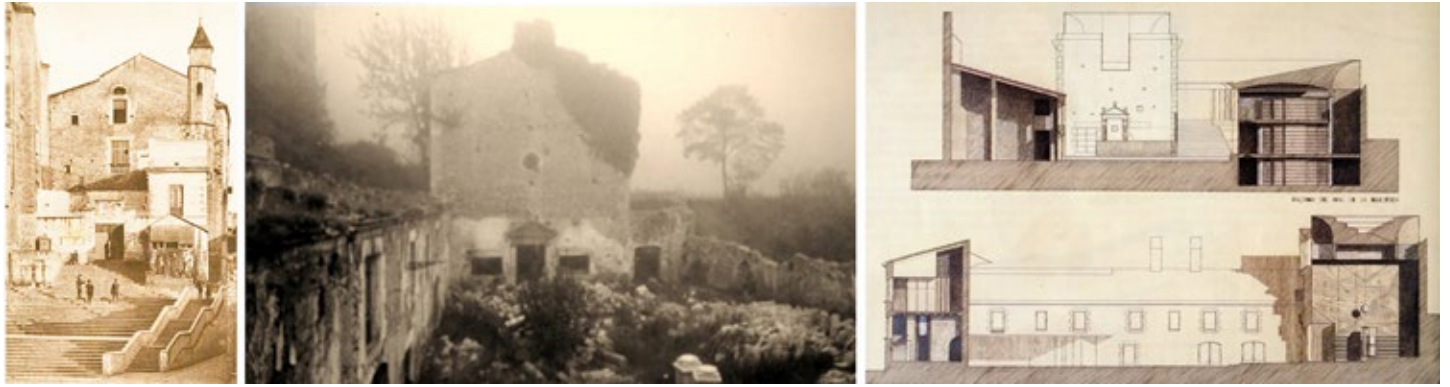
Figura 5. Izquierda: Foto del convento de Sant Domènec utilizado como cuartel antes de ser reutilizado como Universidad. La empinada topografía, propia de enclaves defensivos, limita la actividad urbana. Centro: foto del estado del patio del edificio de Les Aligues con la capilla al fondo antes de las obras de rehabilitación (1986). Derecha: Plano de proyecto de Fuses-Viader arquitectos (1989) La cuidada representación arquitectónica de la propuesta refleja el detallado trabajo de definir la interacción entre antiguo y nuevo. 12
