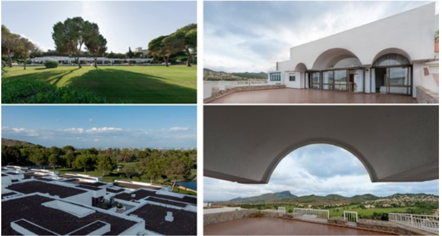
Figura 10. Apartamentos Golf Bungalows (en el texto Bungalows B) y Los Miradores (en el texto Bungalows A). Estado actual.
