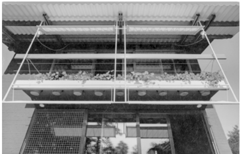
Figura 6. Módulo de la fachada y envoltorio del volumen de vivienda.
