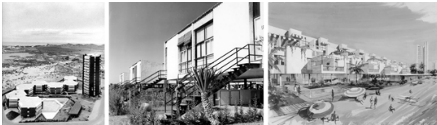
Figura 1. Conjunto Hexagonal (izquierda), Apartamentos Malaret (centro) y Edificio Babilonia (derecha).
